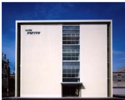
テクノプラザ 正面玄関
