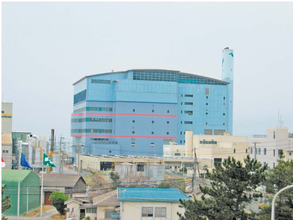
Photo. 5 青岸クリーンセンター(和歌山) Aogishi Clean Center (Wakayama). 写真提供：和歌山市 Photo, a courtesy of Wakayama-shi.
