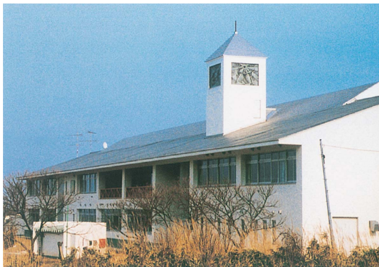
Photo. 4 三厩中学校 (青森県外ヶ浜町)
